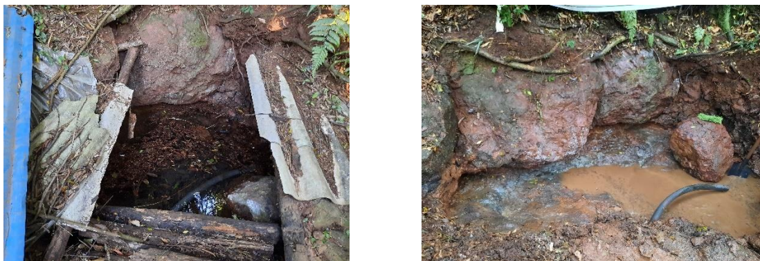
Figura 8. A limpeza da Nascente
