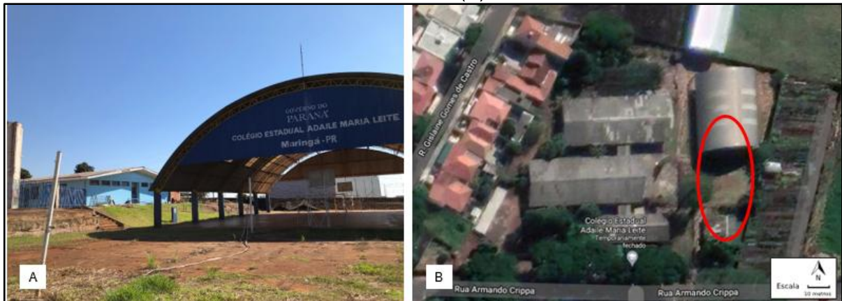
Figura 5: Vista da Quadra de Esportes (A); Localização da Quadra de Esportes no terreno do CEAML (B).
