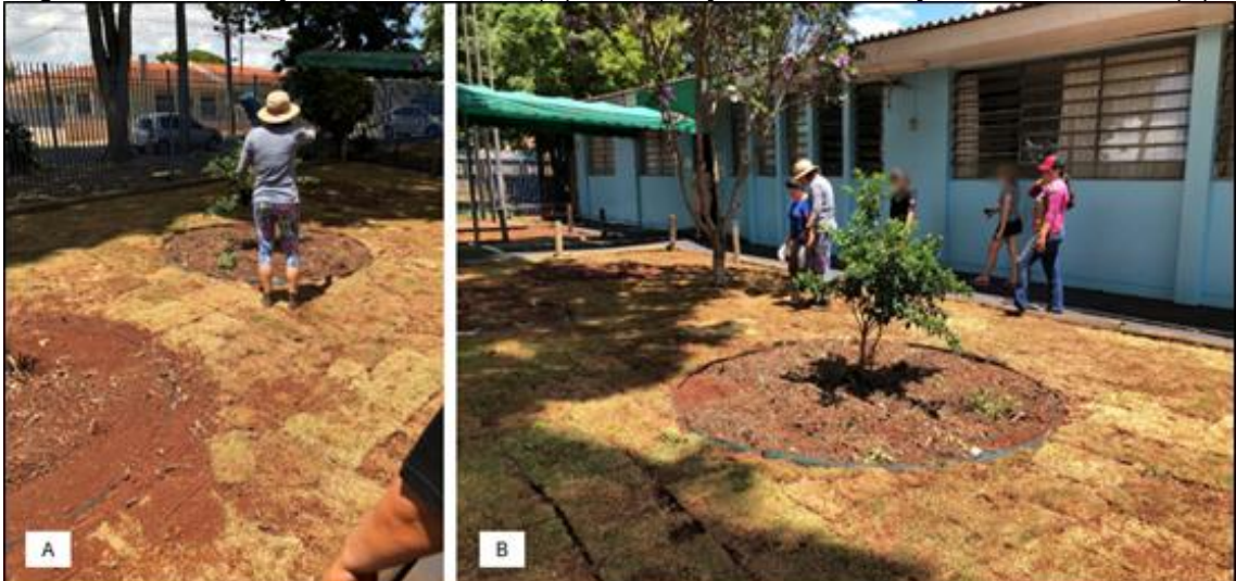
Figura 37: Construção dos canteiros (A); Finalização da construção dos canteiros (B).
