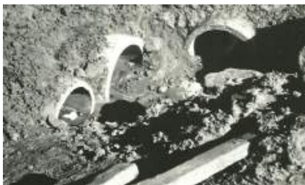
Figura 39: Galeria pluvial (sem data)
