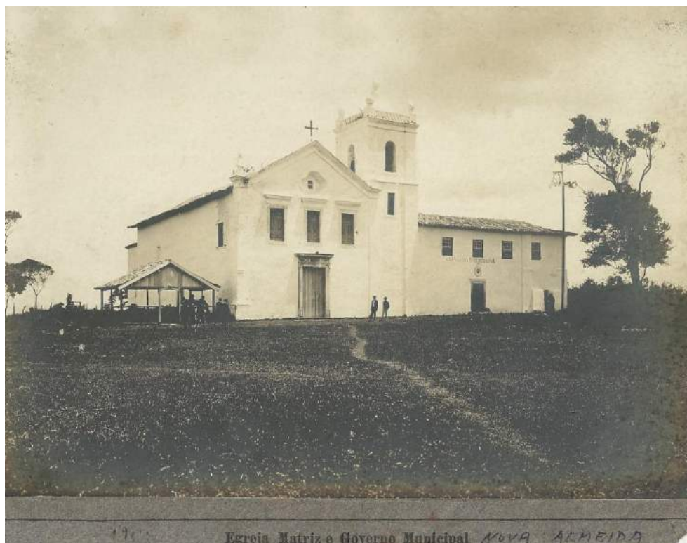
Figura 27: Fachada principal da Igreja e Residência dos Reis Magos, 1911, Nova Almeida, por Eustyquio O'liveir. Fonte: Arquivo fotográfico do IPHAN/ES.
