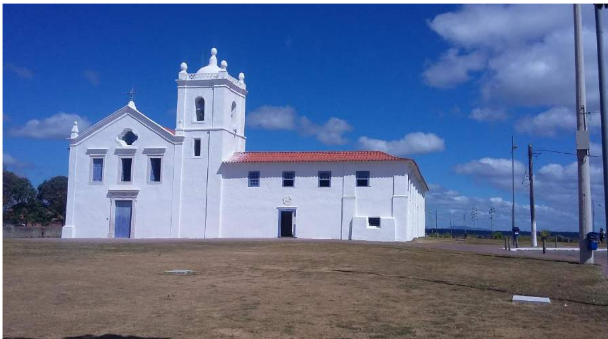
Figura 36: Fachada principal da Igreja e Residência dos Reis Magos, Nova Almeida, 2015. Fonte: Arquivo pessoal da autora.
