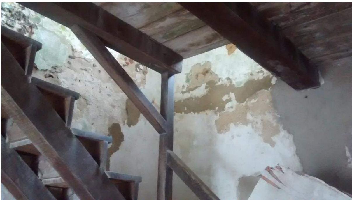
Figura 40: Escada para acesso à Torre dos Sinos, Igreja dos Reis Magos, Nova Almeida, 2016. Fonte: Arquivo fotográfico da autora
