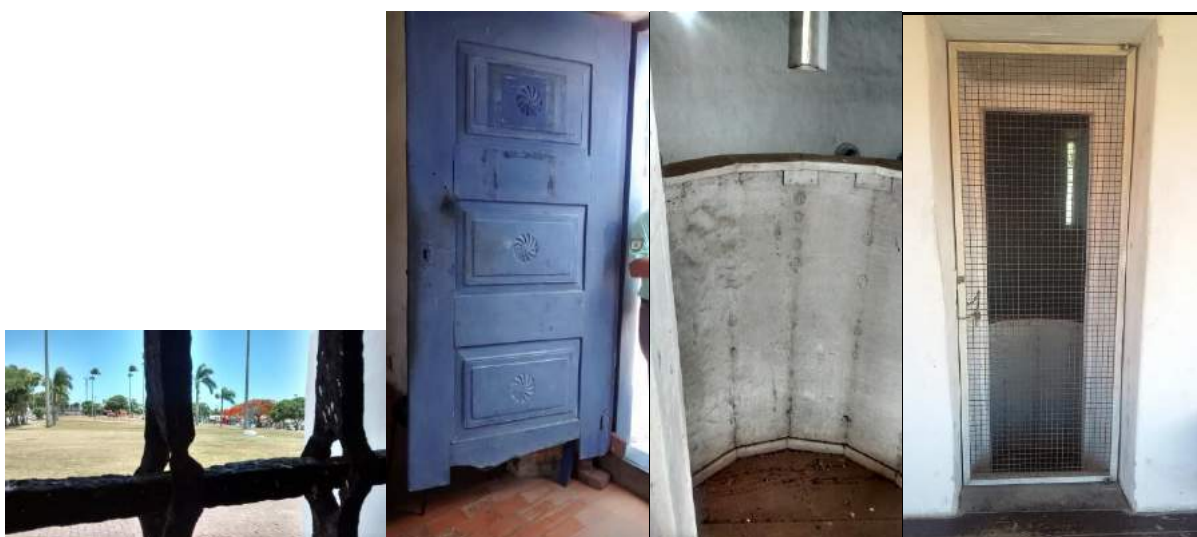
Figura 45: Grade de ferro da janela, porta e púlpito da Igreja e Residência dos Reis Magos, Nova Almeida, 2015/2016. Fonte: Arquivo pessoal da autora.
