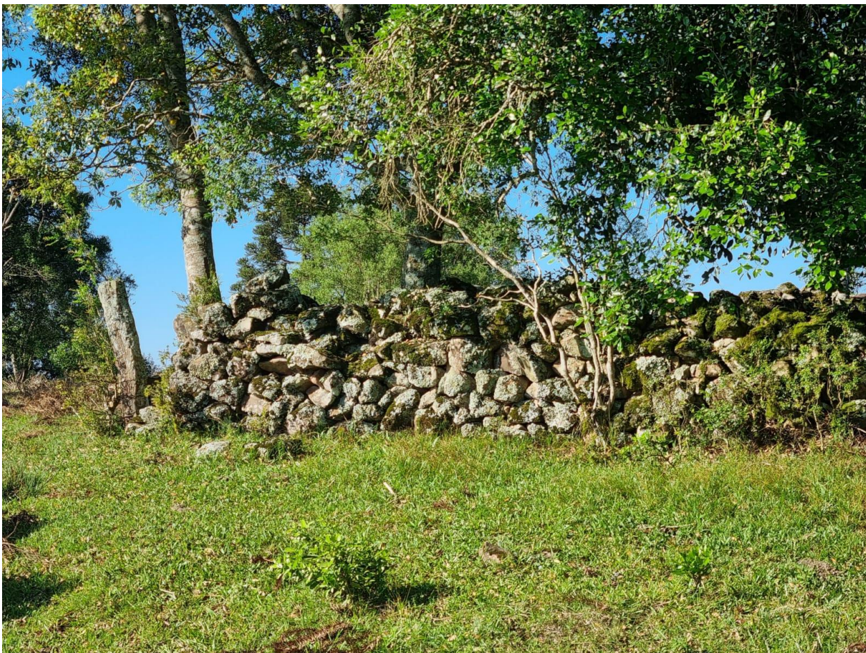
Figura 6: Aproximação dos muros de taipa
