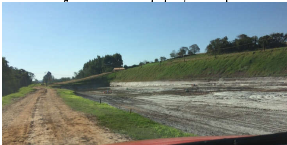
Figura 16 – Processo de preparação do tanque
