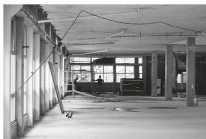
Obra na Biblioteca. (Créditos: Diogo Vasconcellos/MN)
