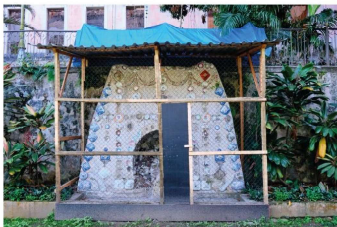
Fonte no Jardim das Princesas higienizada e protegida. créditos Diogo Vasconcellos MN
