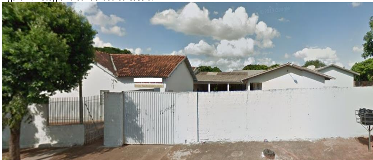
Figura 4: Fotografia da fachada da escola.
