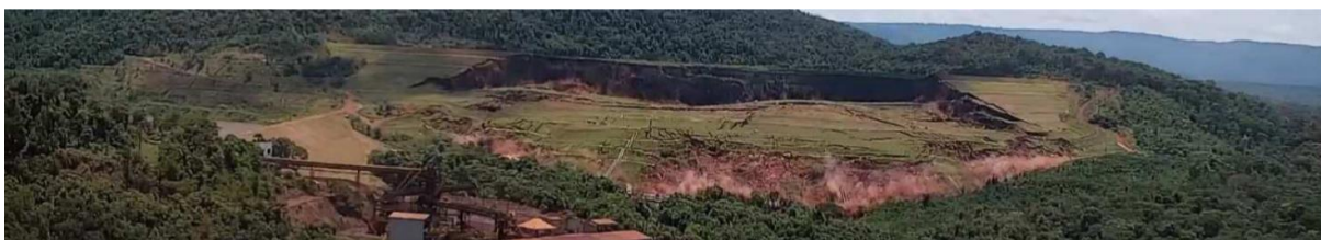
Figura 10 - Momento do rompimento do talude da barragem
