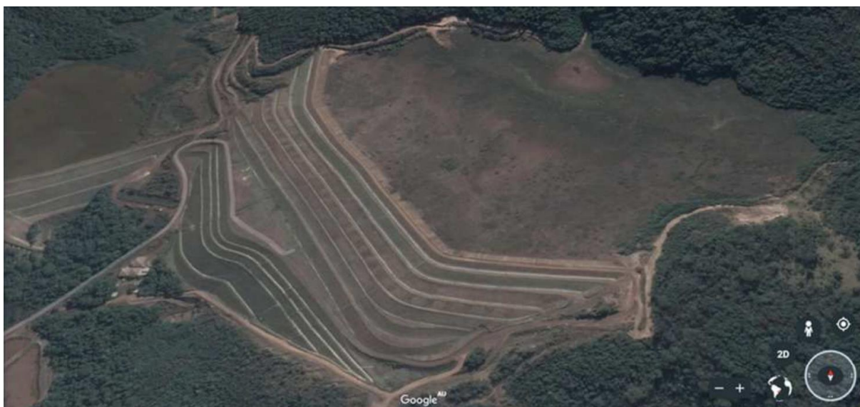
Figura 14 - Vista aérea da barragem em 2018
