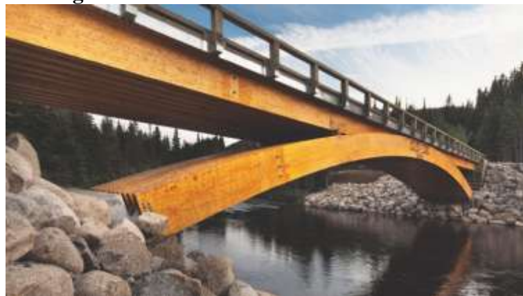
Figura 2.7 – Ponte em madeira laminada colada
