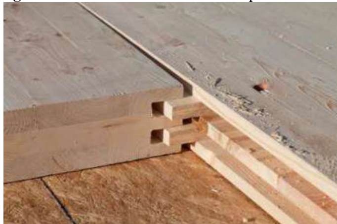
Figura 2.18 – Emendas dentadas entre painéis de CLT
