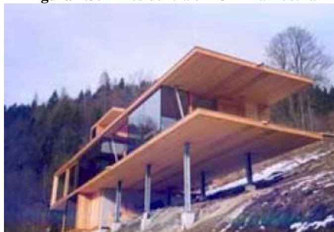
Figura 2.35 – Residência em CLT na Áustria
