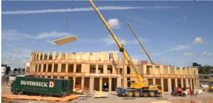
Figura 2.33 – Construção da Universidade de Norwich na Inglaterra
