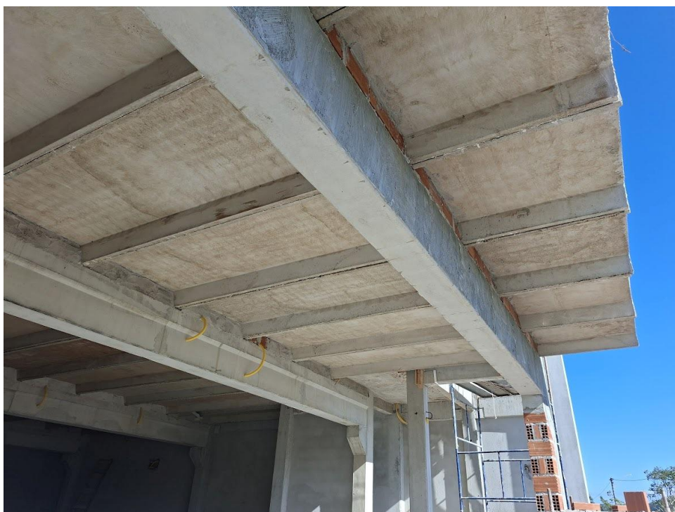
Figura 2 - Exemplar de aplicação de Lajes Canal em 2026
