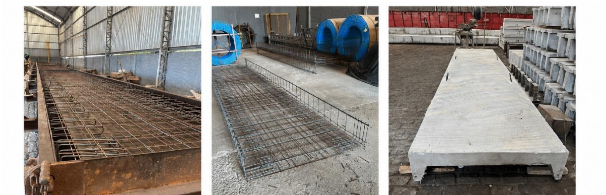
Figura 6 - Processo executivo de uma viga canal
