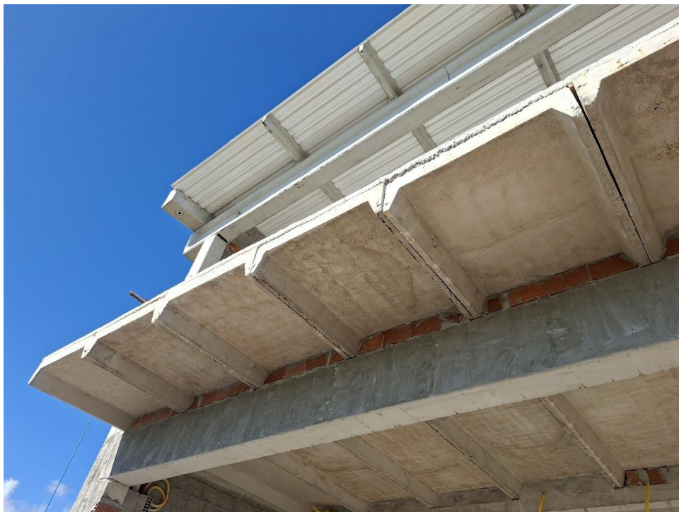
Figura 1 - Exemplar de aplicação de Lajes Canal em 2026
