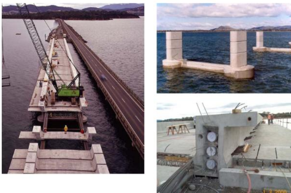
Figura 4 - Foto ou vista do Viaduto Sorell Causeway (Tasmânia, Austrália)
