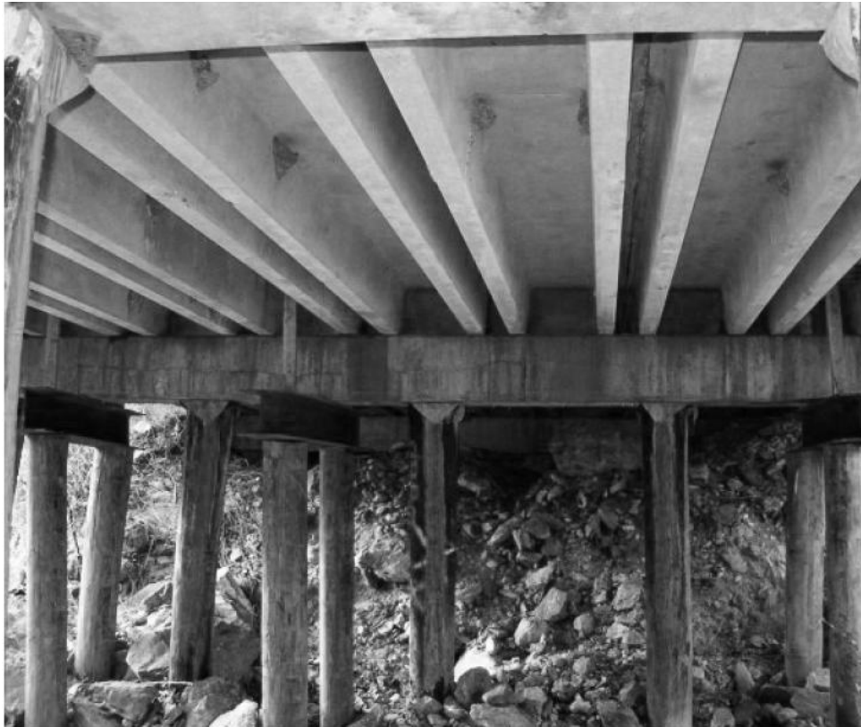
Figura 3 - Vista inferior de ponte com lajes tipo canal em concreto armado
