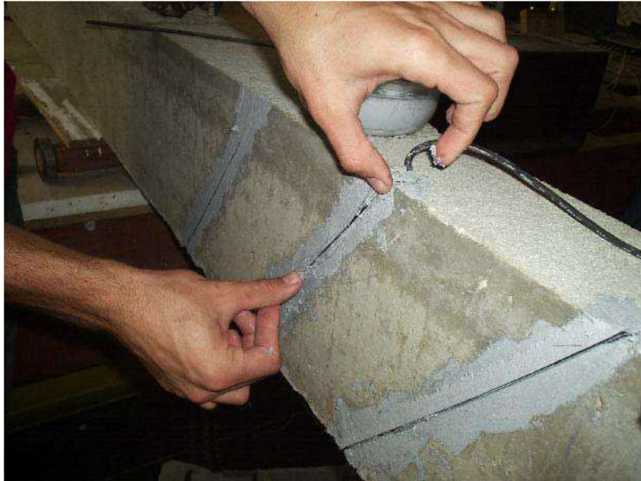
Figura 3.3 – REFORÇO AO CISALHAMENTO COM PRFC – NSM
