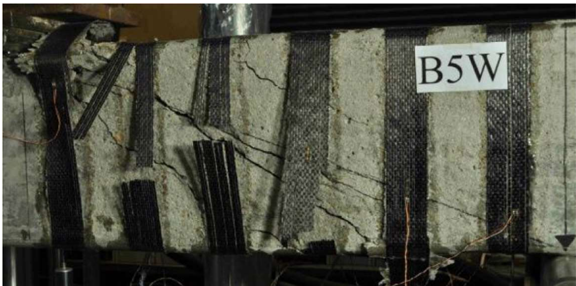
Figura 3.8 – RUPTURA POR TRAÇÃO DO PRFC
