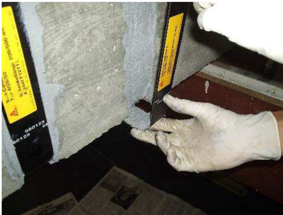
Figura 3.4 – REFORÇO AO CISALHAMENTO COM PRFC – EBR
