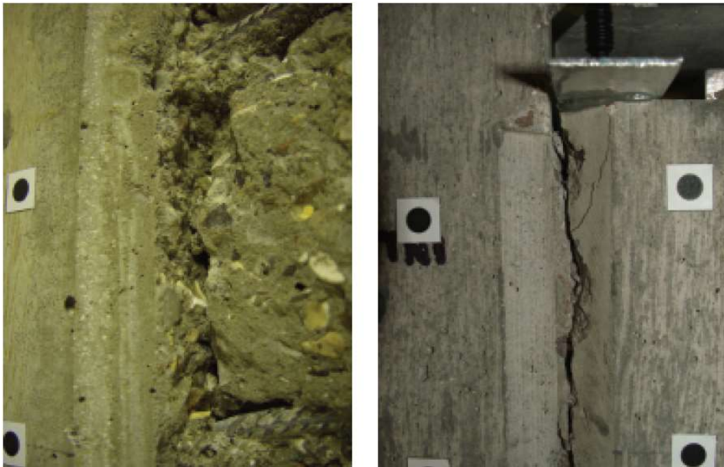
Figura 2.6 - ENGRENAMENTO DOS AGREGADOS
