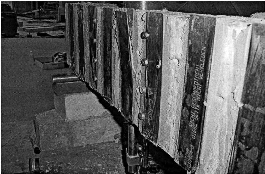
Figura 4.15 – RUPTURA 2 - VIGA Z11-S90 POR ZHANG (2003)
