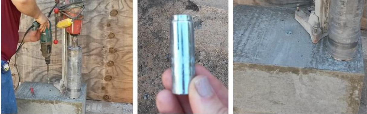
Figura 3.10 – Fixação do maquinário no bloco de concreto
