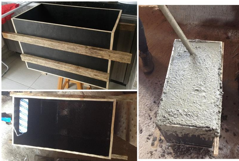
Figura 3.7 – Caixaria, preparo e concretagem dos blocos de concreto
