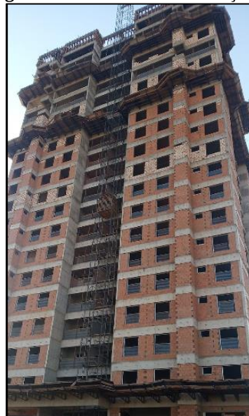
Figura 35 - Edifício em construção V
