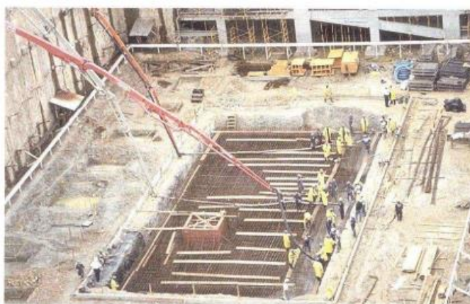
Figura 24 - Sapata central da E-Tower
