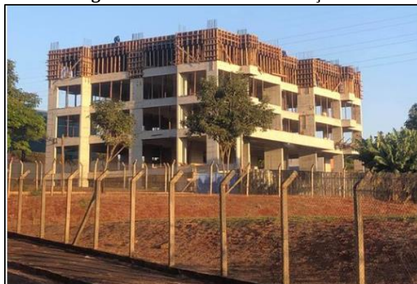
Figura 31 - Edifício em construção I.
