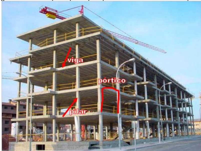
Figura 7 - Identificação da presença de pilares em uma obra da construção civil.
