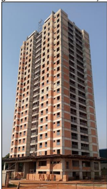
Figura 32 - Edifício em construção II.
