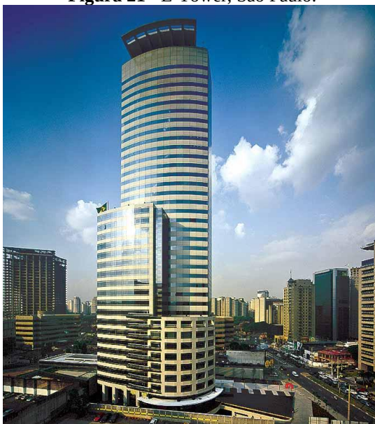
Figura 21 - E-Tower, São Paulo.
