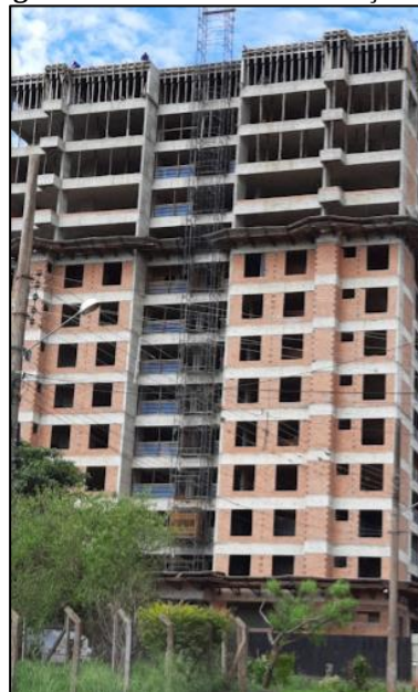
Figura 33 - Edifício em construção III.
