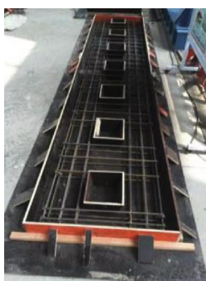
(a) Fabricação da forma da laje
