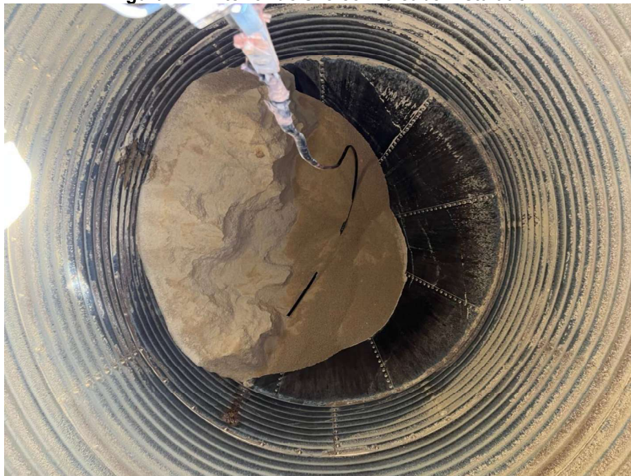
Figura 24 - Interior do silo com o cabo instalado.
