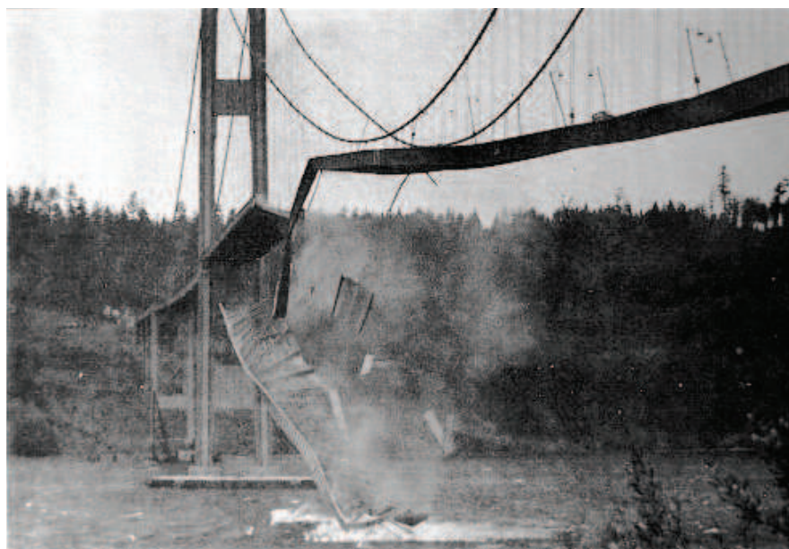
Figura 3 3 - Ponte Tacoma Narrows em colapso
