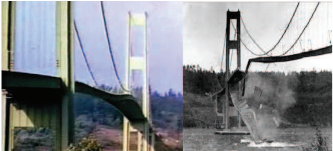
Figura 1.2 Colapso da Ponte de Tacoma
