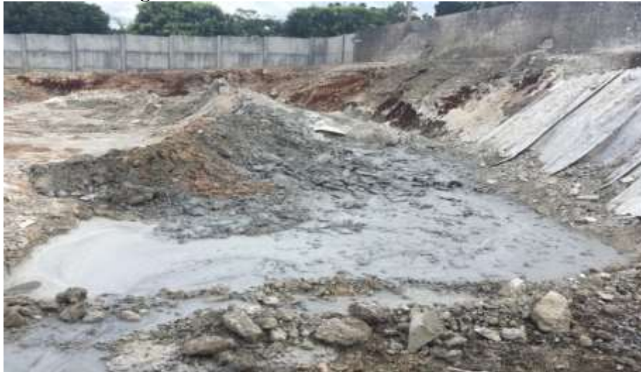
Figura 4.7 - Local de coleta da lama residual de concreto
