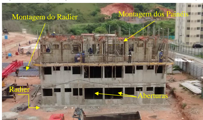
Figura 6: Edificação de paredes de concreto moldadas no local em construção
