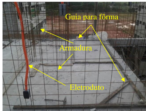
Figura 7: Armaduras nos planos das paredes
