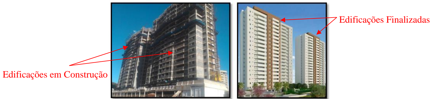
Figura 35: Torres em fase de construção e finalizadas analisadas por Bahia (2015)
