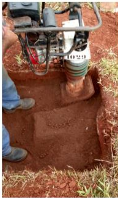
Figura 3-4: a) Processo de compactação da camada; b) Verificação da espessura da camada compactada
