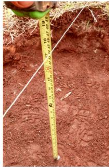
Figura 3-4: a) Processo de compactação da camada; b) Verificação da espessura da camada compactada
