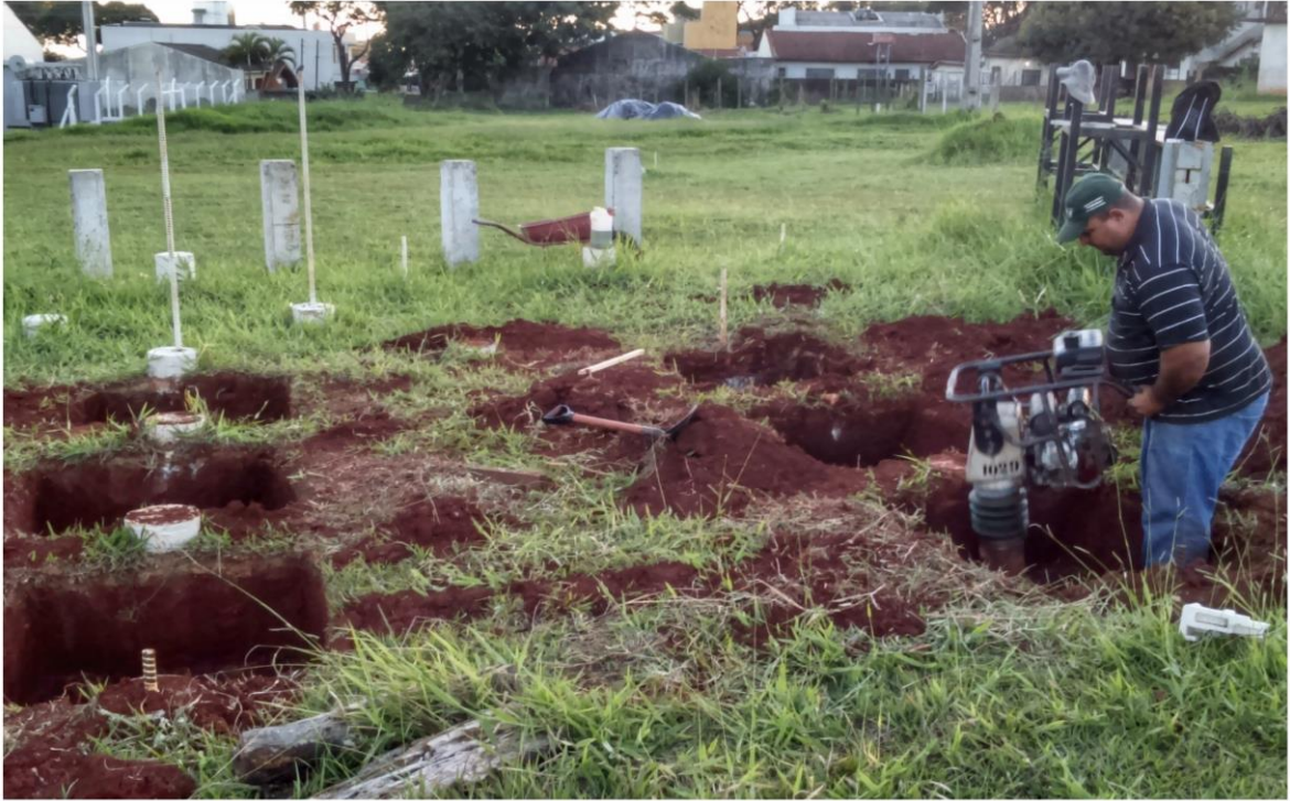
Figura 3-3: Processo de compactação do subleito
