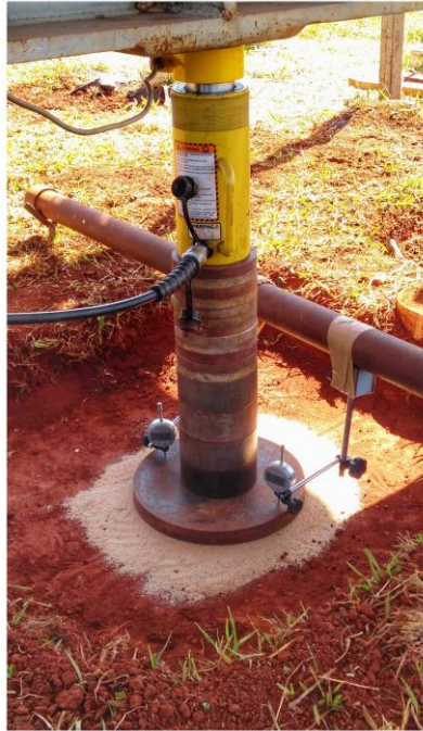
Figura 3-6: Vista Frontal dos relógios fixado na viga de referência
