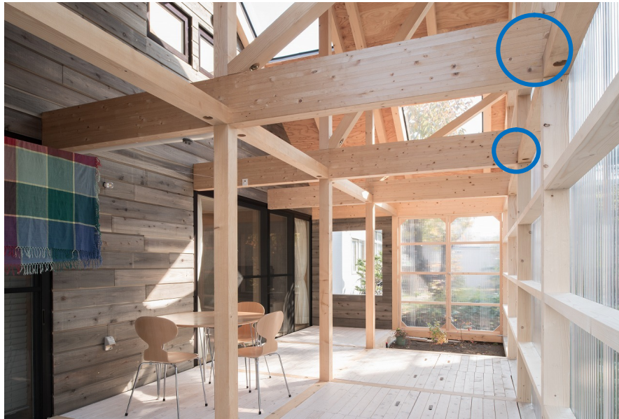
Figura 2.33 – Entalhe na região do apoio
