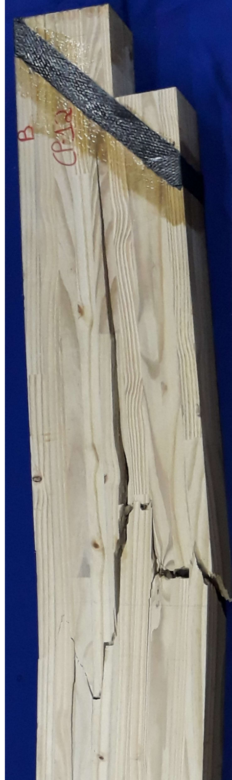
Figura B.7(b) - Ruptura da viga 12: detalhe
