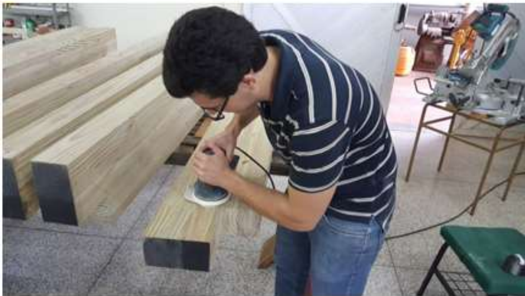
Figura 3.10 – Regularização da superfície
