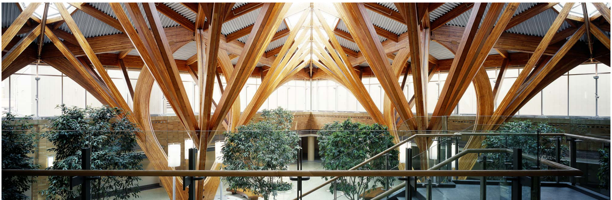
Figura 2.2 – Estrutura de madeira laminada colada (MLC)
