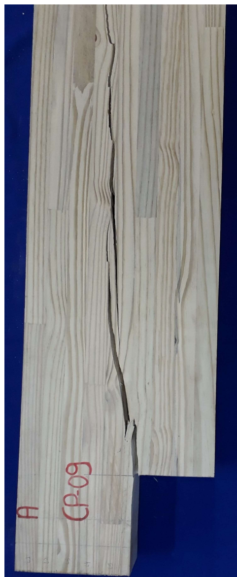
Figura B.3(b) - Ruptura da viga 9: detalhe
