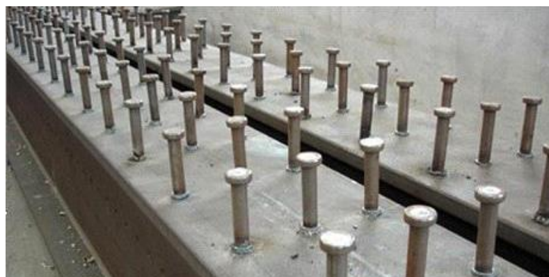
Figura 1.3: Exemplo de perfil metálico com uma grande quantidade de conector pino com cabeça
