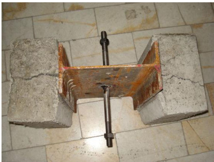
Figura 2.28: Falha devido à fissuração do bloco de concreto, de Maleki e Bagheri (2008)
