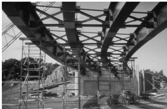
Figura 2.1 – Execução da contenção lateral em vigas de pontes curvas
