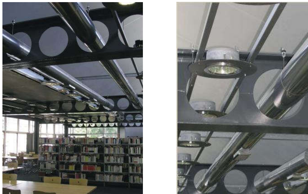
Figura 1.9 – Passagem de tubulações
