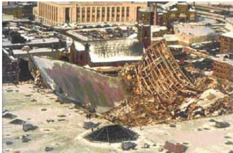
Figura 1.1 - Colapso do telhado da arena de Hartford
