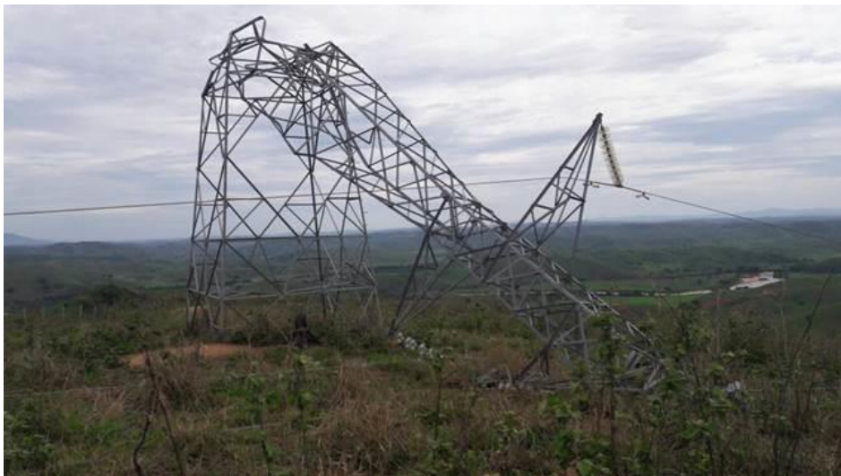
Figura 1.2 – Colapso de torre de fornecimento de energia em Minas Gerais, 2016
