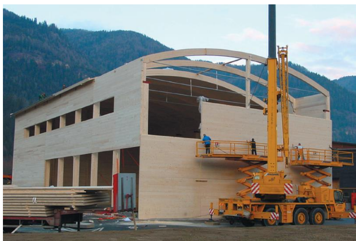
Figura 2.6 – Galpão construído em CLT e MLC – Fase de construção
