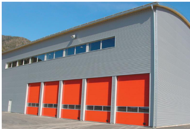
Figura 2.7 – Galpão construído em CLT e MLC – Após o término da construção
