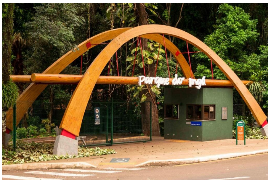
Figura 2.3 – Detalhe de arco de madeira laminada colada
