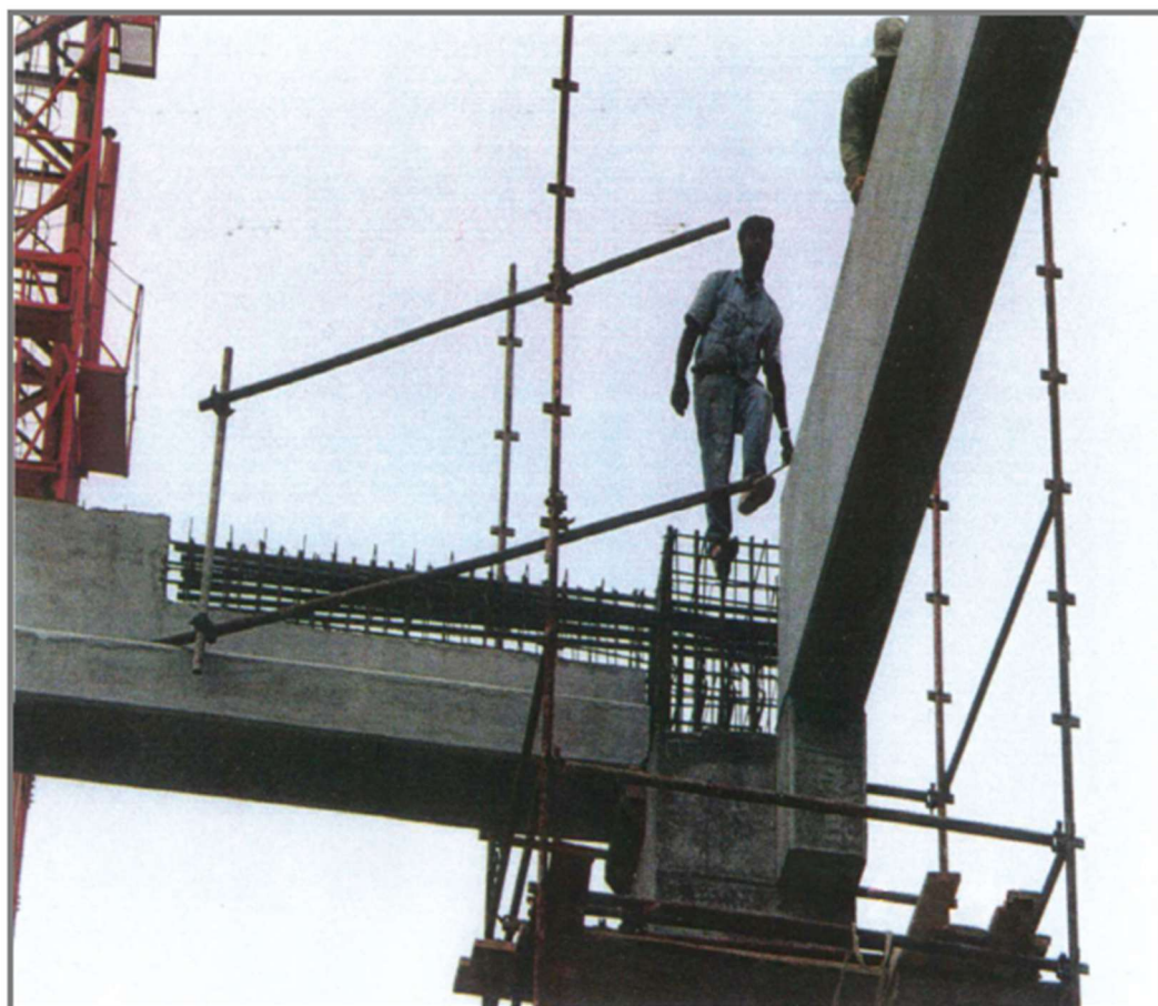
Figura 2.1 – Ligação viga-pilar rígida com concretagem em obra
