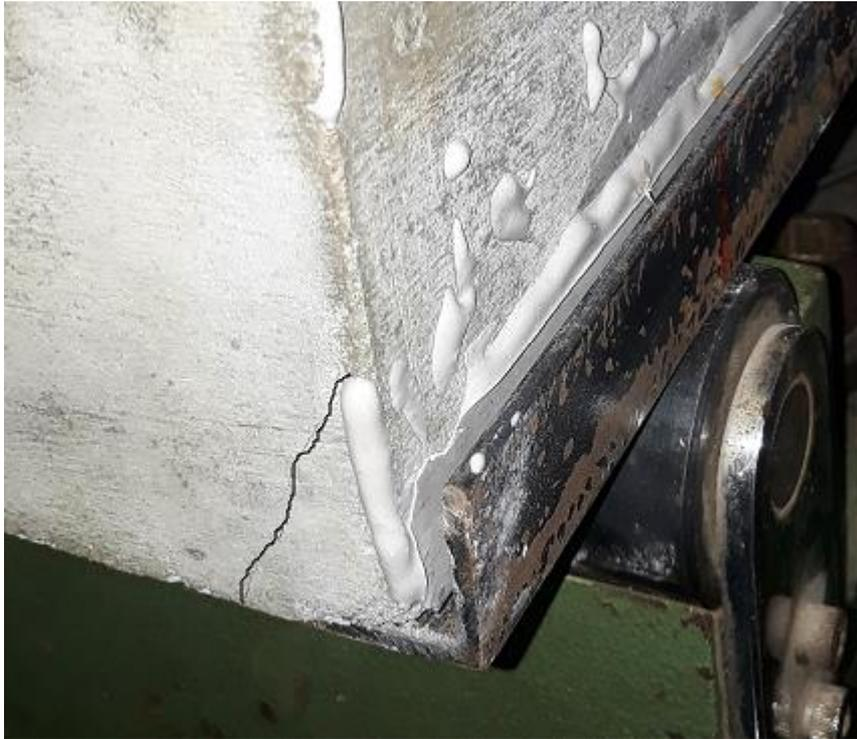
**Figura 6.18 – Fissuras da Viga B1**
