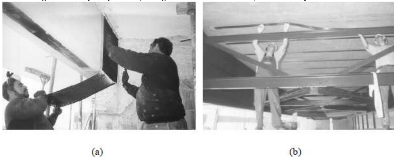
Figura 16 - Aplicação de a) colagem externa úmida e b) laminados pré-fabricados
