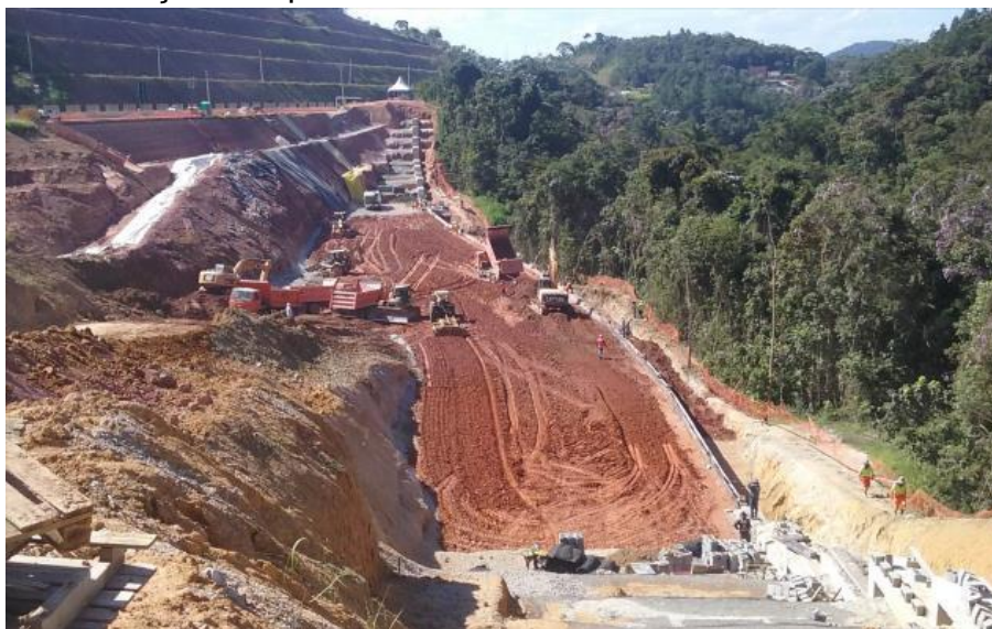
Figura 2.23 - Execução das primeiras camadas
