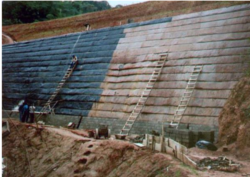
Figura 2.18 - Primeiro muro em solo reforçado do Brasil
