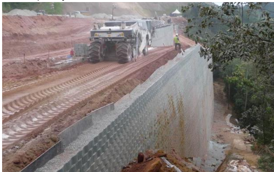
Figura 2.25 - Compactação do aterro
