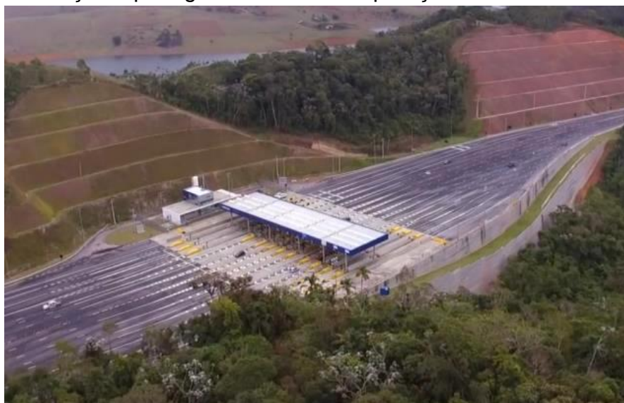
Figura 2.26 – Praça de pedágio concluída em operação
