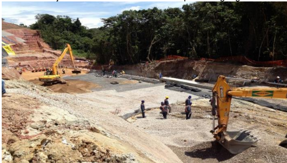
Figura 2.24 - Execução do colchão de brita envolto por uma geogrelha
