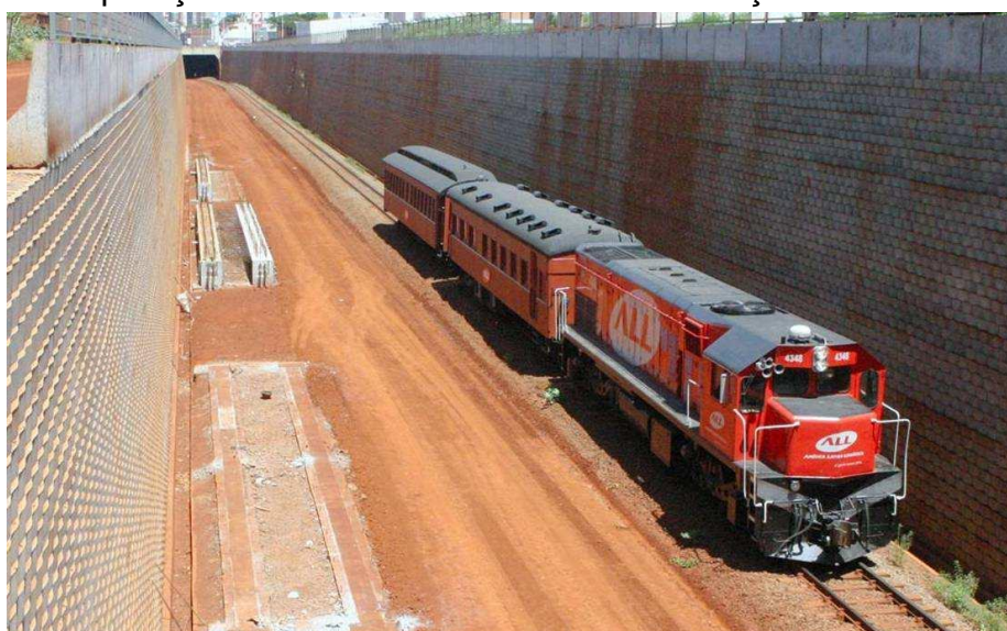
Figura 2.22 – Operação da linha férrea durante a construção do muro
