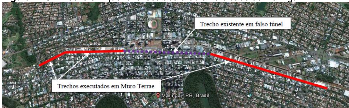
Figura 2.19 - Trecho em que foi executada a obra na cidade de Maringá-PR
