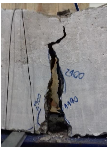
Figura 62 – Ruptura da armadura tracionada – Viga VFR
