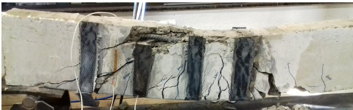
Figura 90 – Ruína da viga – Viga VC3
