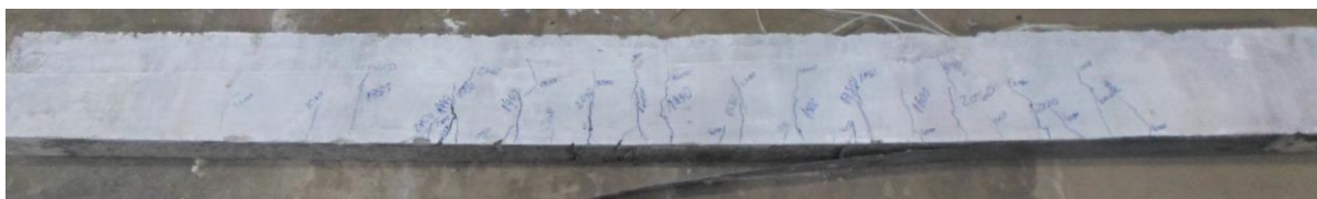
Figura 66 – Fissuras – Viga VF0
