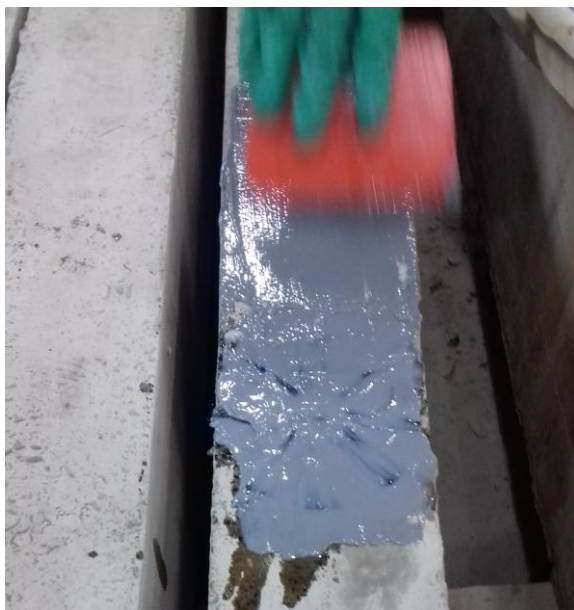
Figura 45 – Aplicação do adesivo sobre o substrato de concreto
