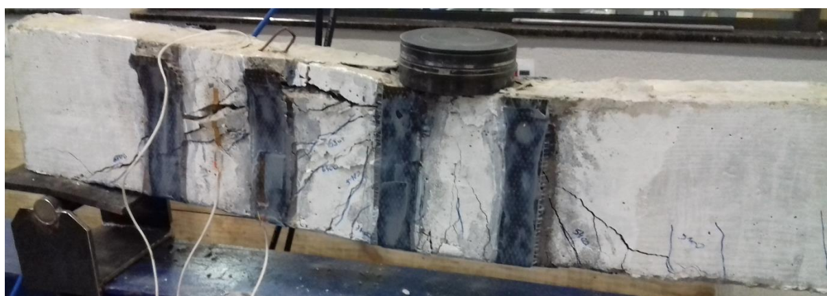
Figura 86 – Fissuras – Viga VC1
