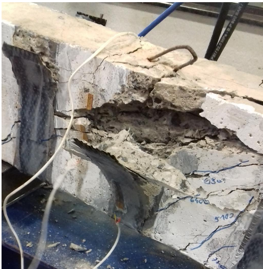
Figura 85 – Panorama de fissuração– Viga VC1
