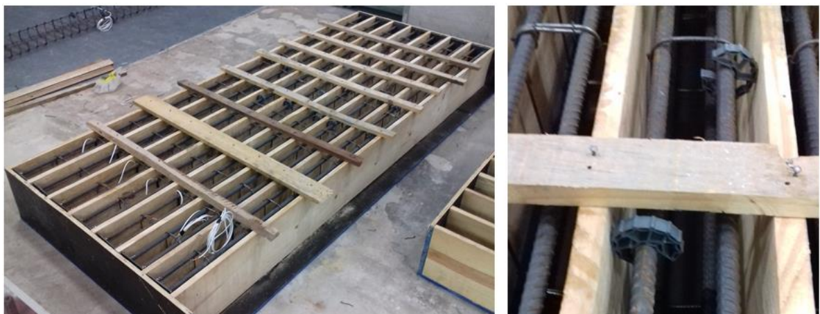
Figura 36 – (a) Fôrmas com armadura posicionada; (b) espaçadores da armadura
