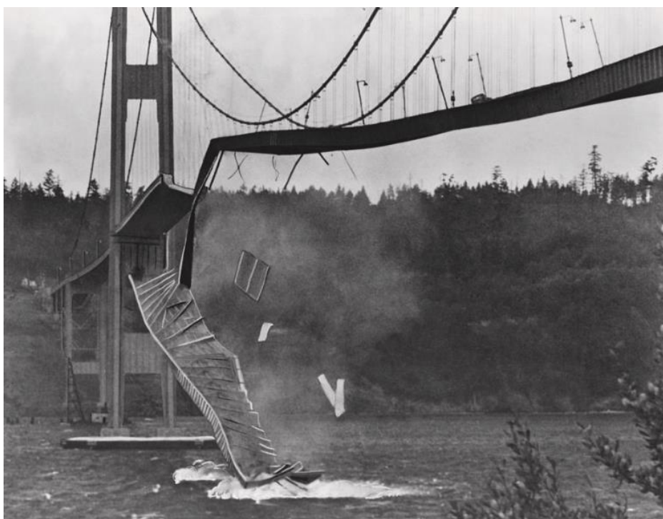
Figura 2.40: Colapso da ponte Tacoma Narrows, em 1940
