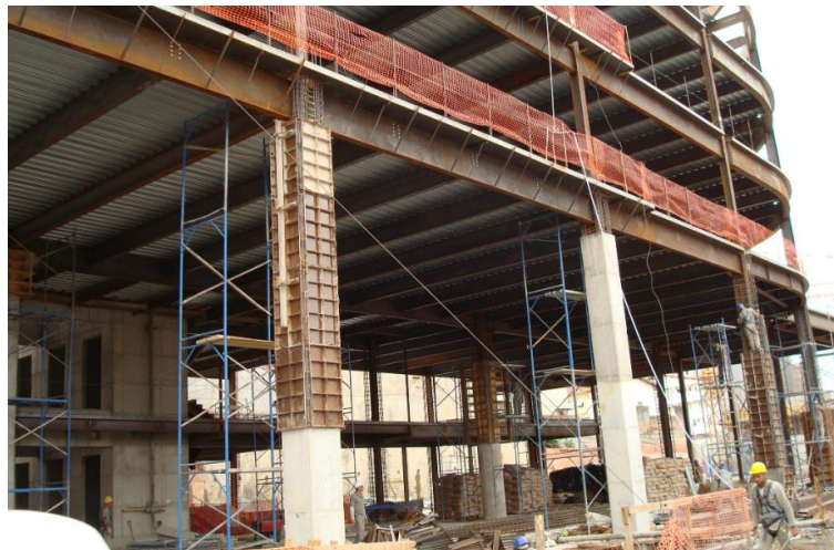
Figura 2.1: Estruturas mistas de concreto e aço
