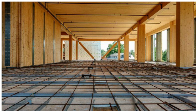
Figura 2.2: Lajes mistas de madeira e concreto
