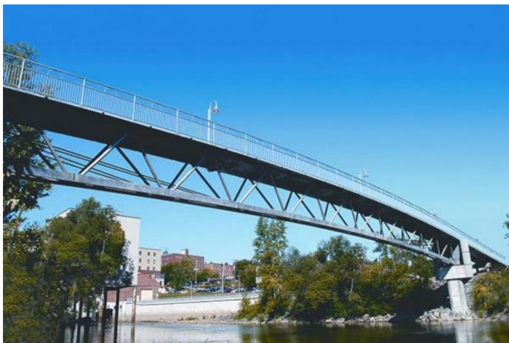
Figura 2.27: Passarela de UHPC em Sherbrooke, Canadá
