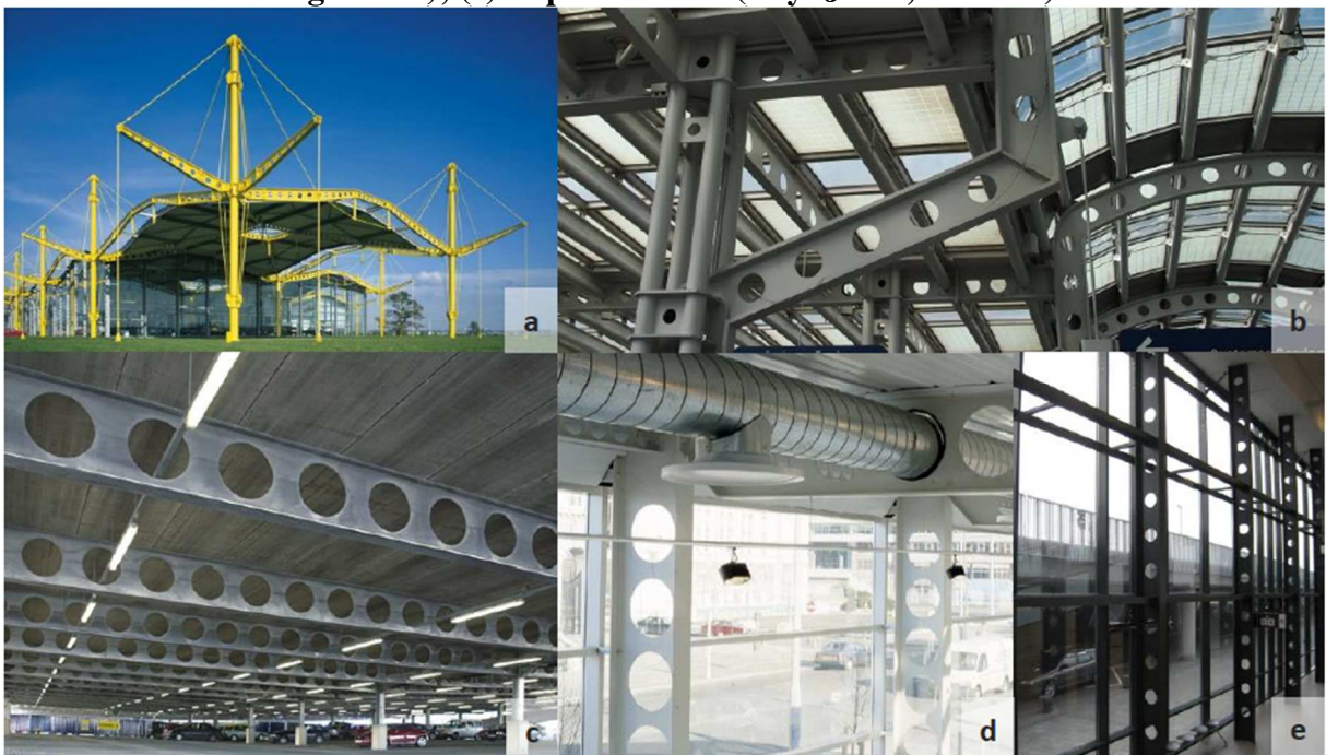
Figura 1.1 - Exemplos de aplicações para perfis celulares: (a) Centro de Distribuição da Renault (Swindon, Inglaterra); (b) Aeroporto Internacional O'Hare de Chicago (EUA); (c) Estacionamento da Ikea (Leeds, Inglaterra); (d) Garagem da Porsche (Liverpool, Inglaterra); (e) Supermercado (Reykjavik, Islândia)
