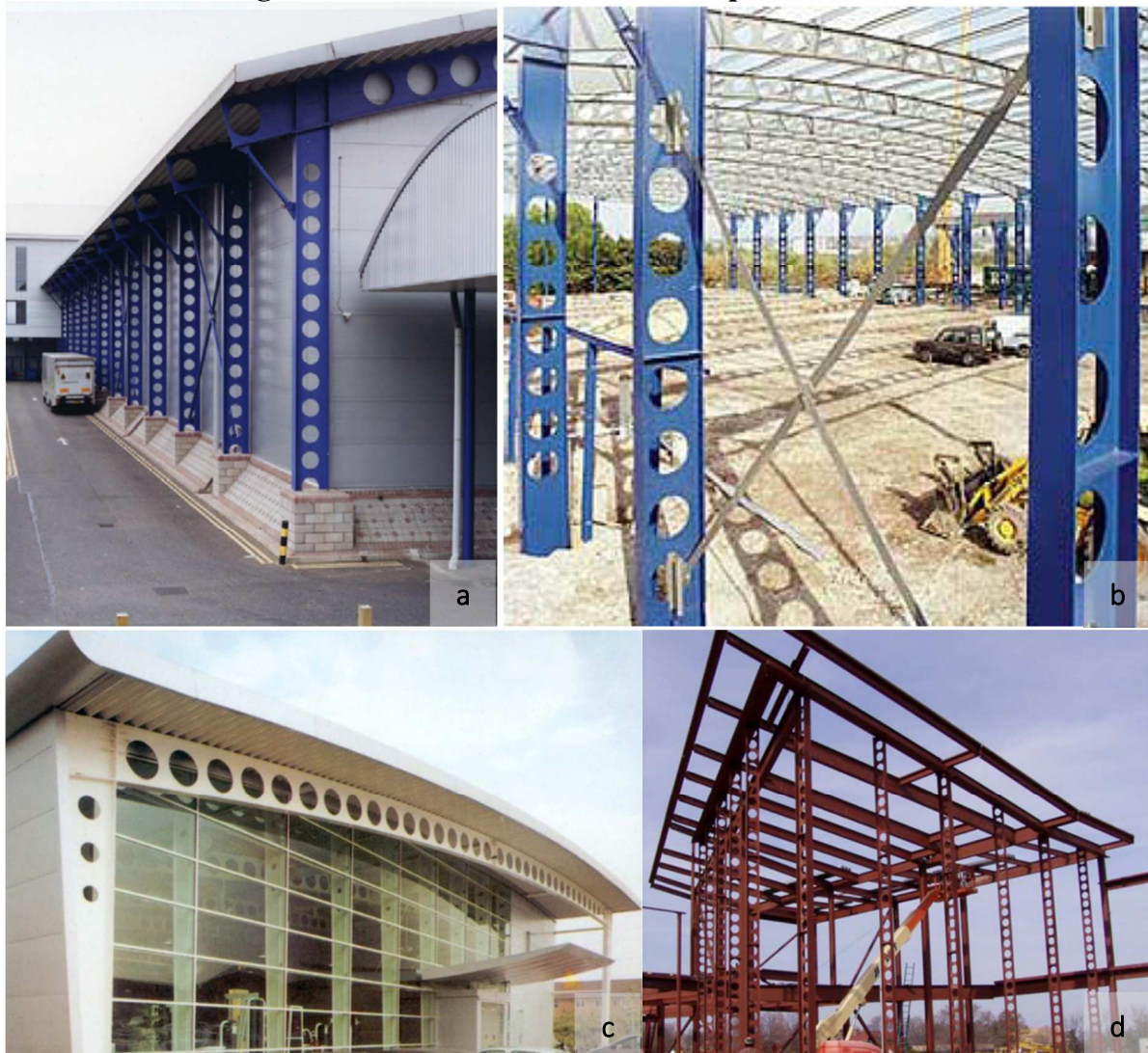
Figura 1.6 – Pórticos com colunas em perfis celulares
