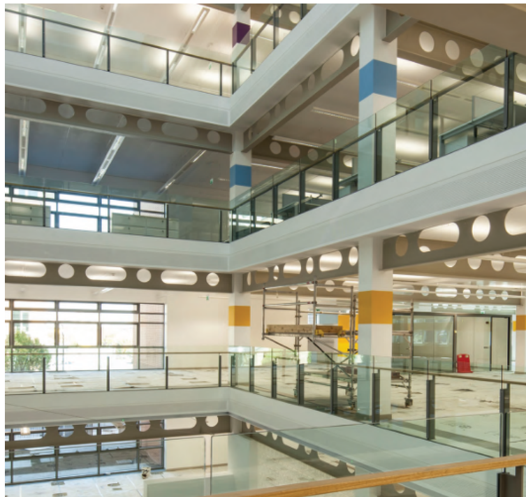
Figura 1.3: Edifício Birmingham Council Offices
