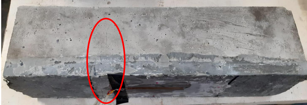
Figura 54 – Amostra Concreto C40 (reforço 30mm) após o Ensaio de Flexão 4 pontos
