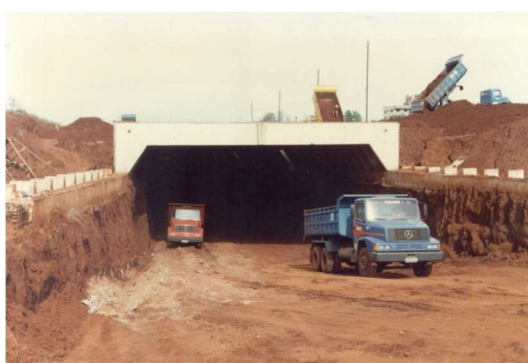
Figura 3.8 – Etapa da escavação do túnel Fonte: URBAMAR, [s.d.]
