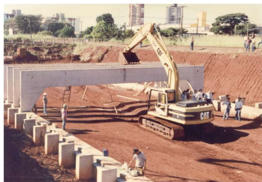
Figura 3.7 – Posicionamento das vigas principais Fonte: URBAMAR [s.d.]
