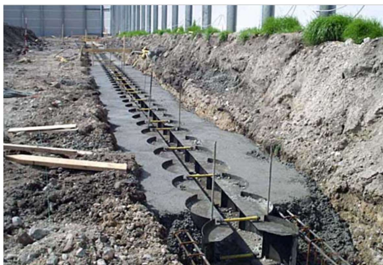
Figura 2.12 – Execução do muro guia com cofragem metálica para estacas secantes Fonte: Meireles & Matins (2006).
