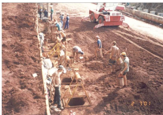
Figura 3.6 – Execução das estacas escavadas da contenção do túnel Fonte: URBAMAR [s.d.]
