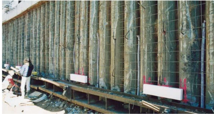
Figura 2.8 – Cortina de estacas com malha eletro soldadas Fonte: (MEIRELES; MARTINS, 2006)
